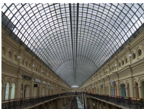
Рис. 8. Перекрытия между торговыми рядами (ГУМ) [1]
