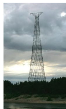
Рис. 7. Опорная башня на Оке [1]
