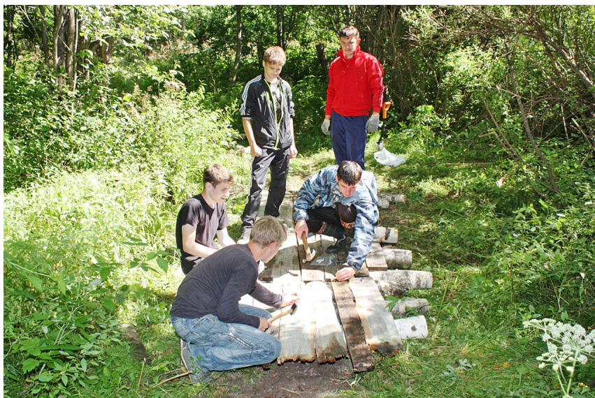
Фото 1. Поездки участников проекта «София». Строительство мостика на тропинке к Никольскому источнику.
